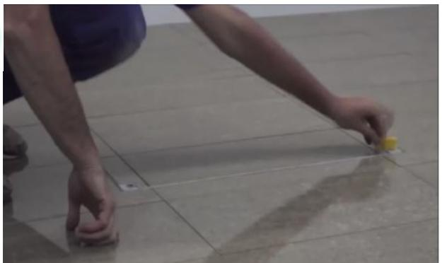
Reinigen Sie den restlichen Teil der Schachtabdeckung, schließen Sie sie und befestigen Sie die Schrauben und Abdeckkappen.
