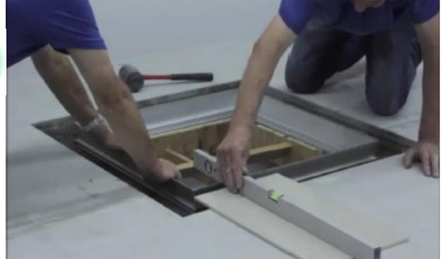
Setzen Sie die Schachtabdeckung in die Aussparung am Boden und richten Sie sie flächenbündig auf die Höhe des Endbodenbelags aus. Es sollten umlaufend mindestens 130 mm Platz zum Ausbetonieren sein.
