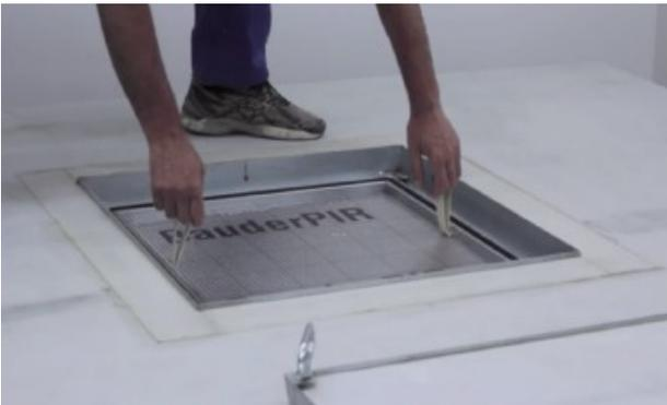
Legen Sie die Thermoeinlage in den Außenrahmen. Achtung: Die Thermoeinlage ist nicht begehbar!
