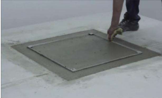
Lassen Sie den Beton vollständig aushärten. Sobald der Rahmen eine feste Verbindung mit dem Beton hat, kann die Schachtabdeckung nicht mehr verrutschen. Hat der Beton ca. 80 % seiner Festigkeit erreicht, reinigen Sie die sichtbaren Flächen der Schachtabdeckung.
