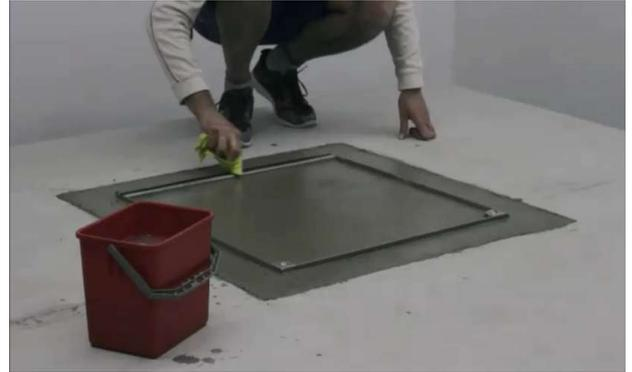
Lassen Sie den Beton vollständig aushärten. Sobald der Rahmen eine feste Verbindung mit dem Beton hat, kann die Schachtabdeckung nicht mehr verrutschen. Hat der Beton ca. 80% seiner Festigkeit erreicht, reinigen Sie die sichtbaren Flächen der Schachtabdeckung.
