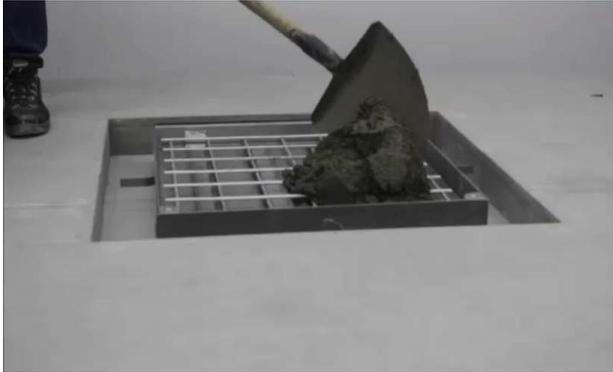
Legen Sie das Bewehrungsgitter in die Wanne, befüllen Sie die Wanne vollständig oder bis zur Unterkante des Endbodenbelags und betonieren Sie die Schachtabdeckung umlaufend vollständig oder bis zur Unterkante des Endbodenbelags an. Achten Sie darauf, dass das Bewehrungsgitter vollständig mit Beton ummantelt ist und schützen Sie die Schrauben und Ränder vor Betonspritzern.
