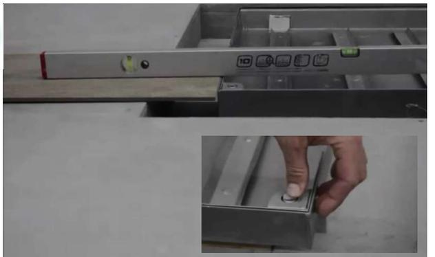
Schließen Sie die Abdeckung und befestigen Sie die Schrauben und Abdeckkappen. Überprüfen Sie nochmal die korrekte Position der Schachtabdeckung.
