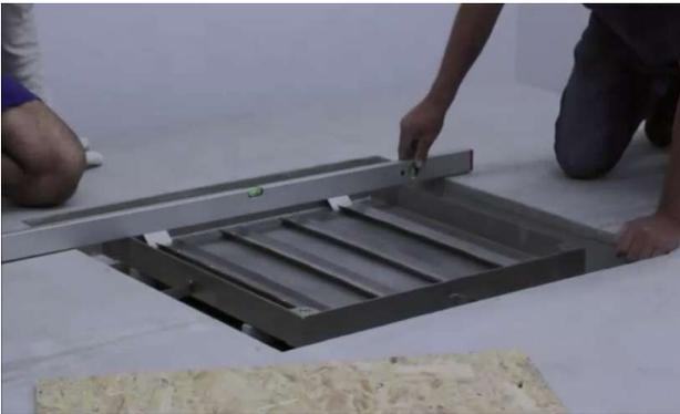
Setzen Sie die Schachtabdeckung in die Aussparung am Boden und richten Sie sie flächenbündig auf die Höhe des Endbodenbelags aus. Es sollten umlaufend mindestens 130mm Platz zum Ausbetonieren sein. **Achtung:** Die Gasdruckfedern dürfen NICHT montiert sein!
