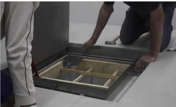
Öffnen Sie die Abdeckung mit den Hebeschlüsseln und bringen Sie eine ausreichende Verschalung des Rahmens an.
