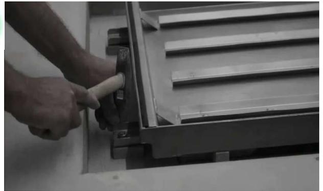
Fixieren Sie die Schachtabdeckung an den Befestigungsankern der Scharnierseite mit Hilfe der mitgelieferten Schlagbolzen. Legen Sie dazu ein Ausgleichplättchen unter, bohren Sie die Löcher vor, schlagen Sie die Bolzen hinein und drehen Sie die Schrauben fest.
