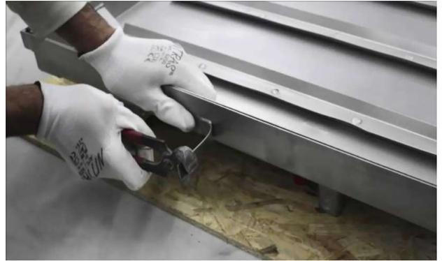
Biegen Sie die Maueranker so, dass später eine zuverlässige Verankerung im Beton sichergestellt ist.
